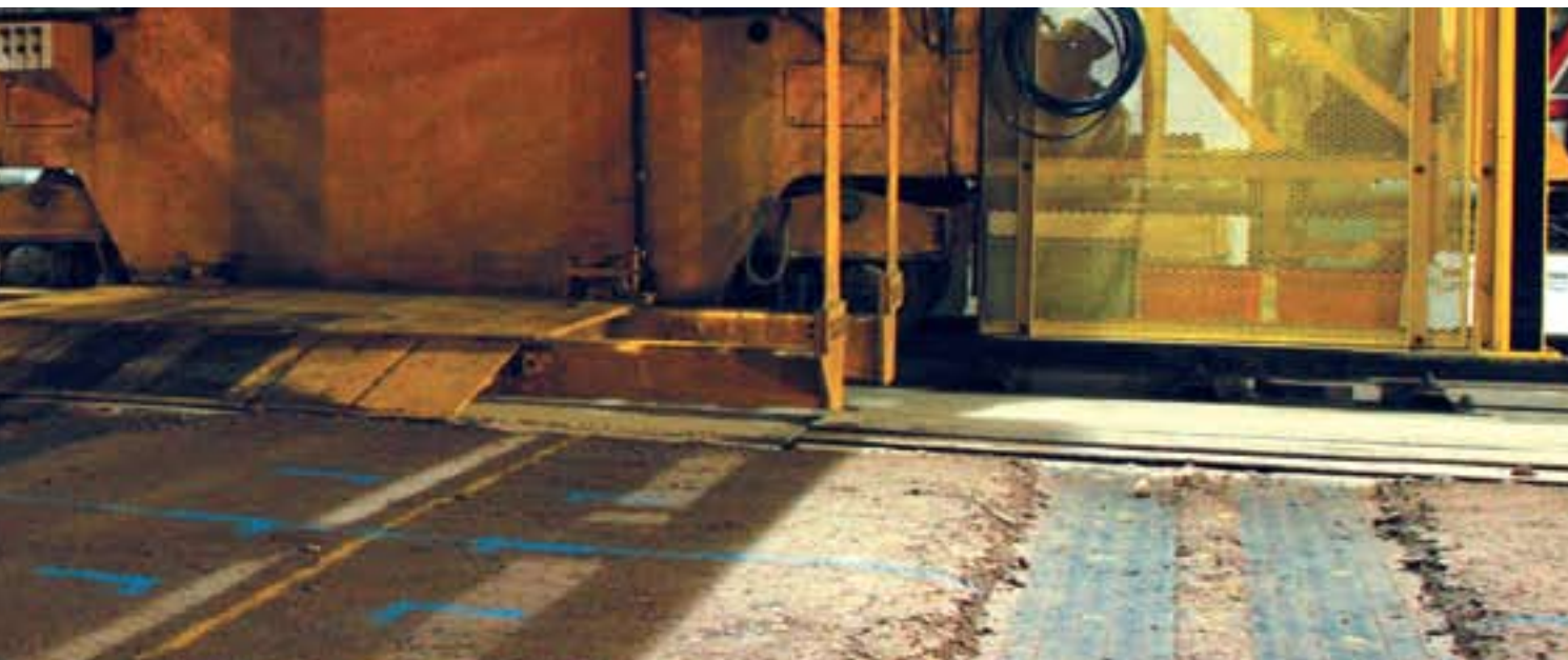
Dopravní zkouška v TRL potvrdila lepší účinnost geomříže TriAx ve srovnání s dvouosými geomřížemi.
