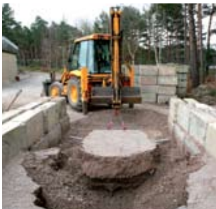
Odkrytí geomříže TriAx při zkouškách pro stanovení poškození při instalaci v TRL.
