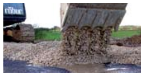
Zrnitý materiál je sypaný na geomříže TriAx před hutněním.
