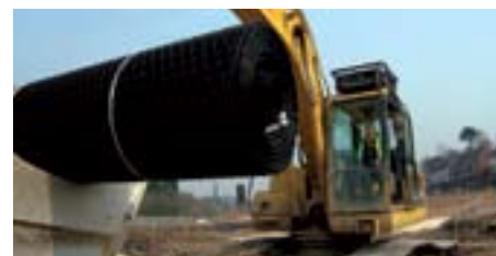
S geomříží TriAx je možné manipulovat strojně nebo ručně dvěma muži.
