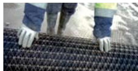
Nerovznutá geomříž TriAx na staveništi.
